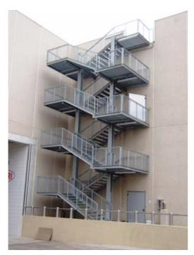
Le strutture portanti sono realizzate in profilati di acciaio tipo 1 (tensione minima di snervamento di 2400 da N/cmq) ISO Fe 37 - Fe 42 B
